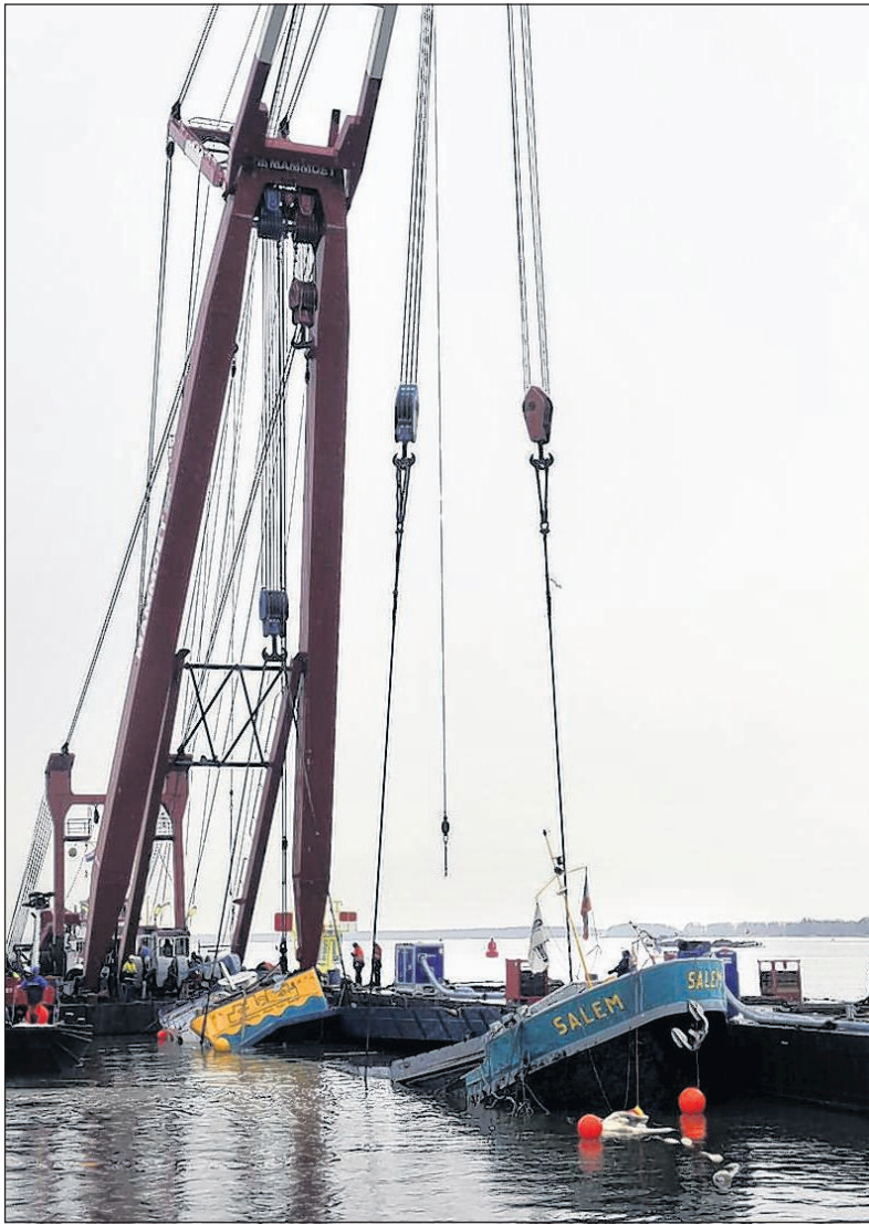
Het gezonken schip wordt met een kraan opgetakeld uit het water.
